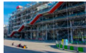
la façade du côté de la piazza
